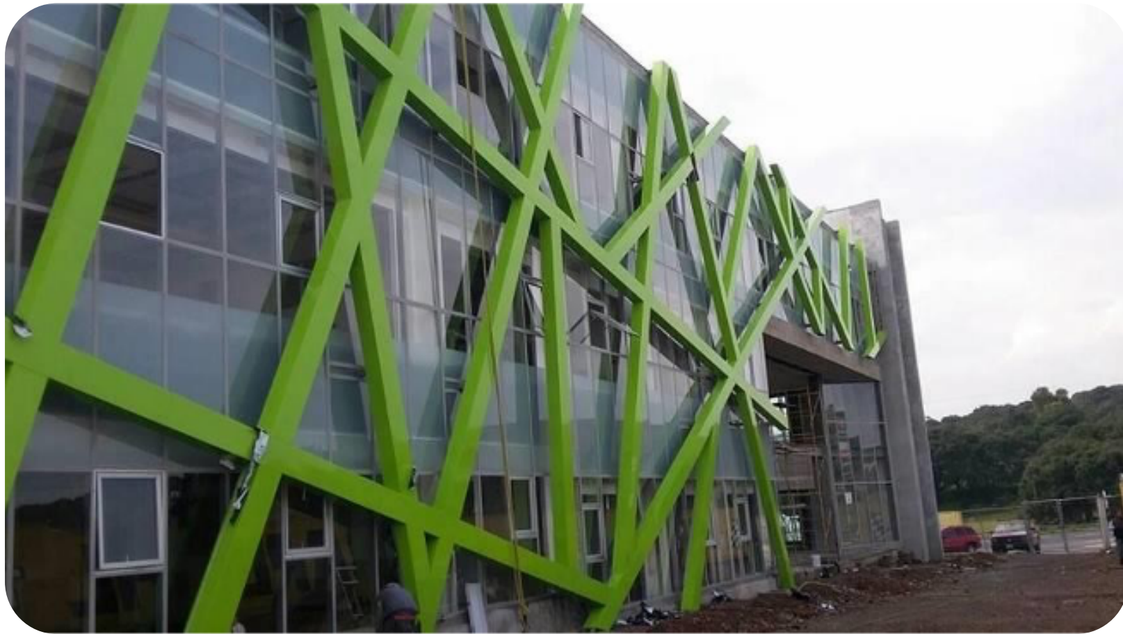
Hotel Autopista Mex- Qro Suministro e instalación de panel de aluminio
