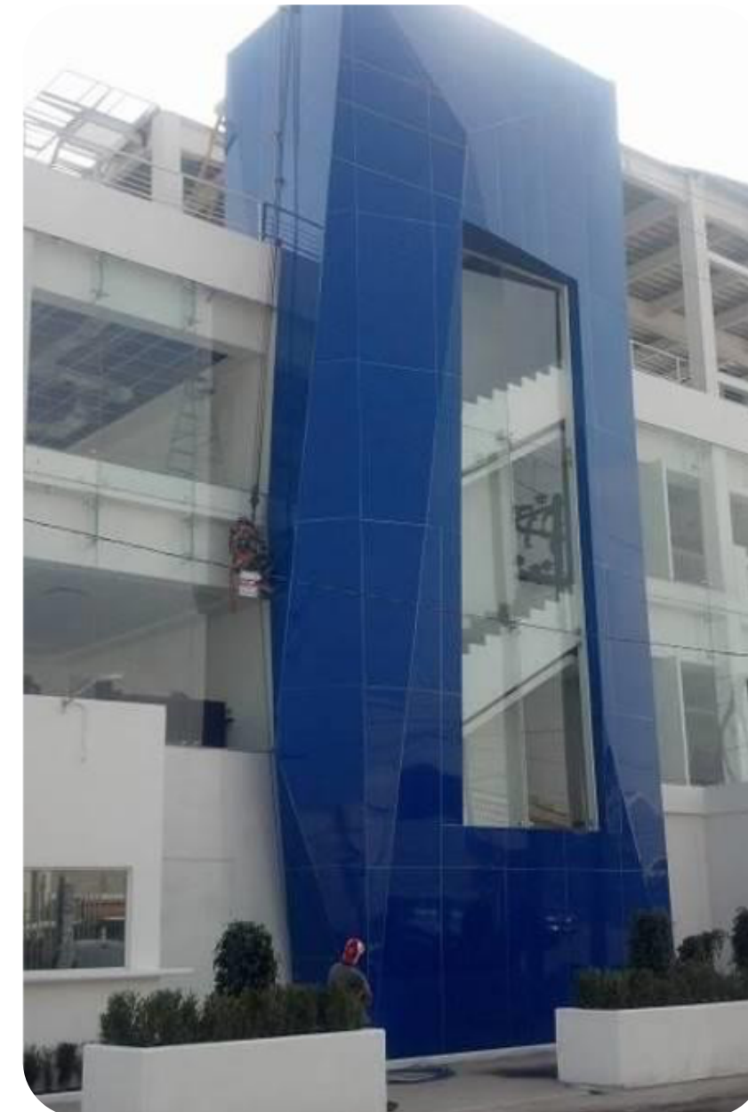
Gasoductos Suministro e instalación de panel de aluminio
