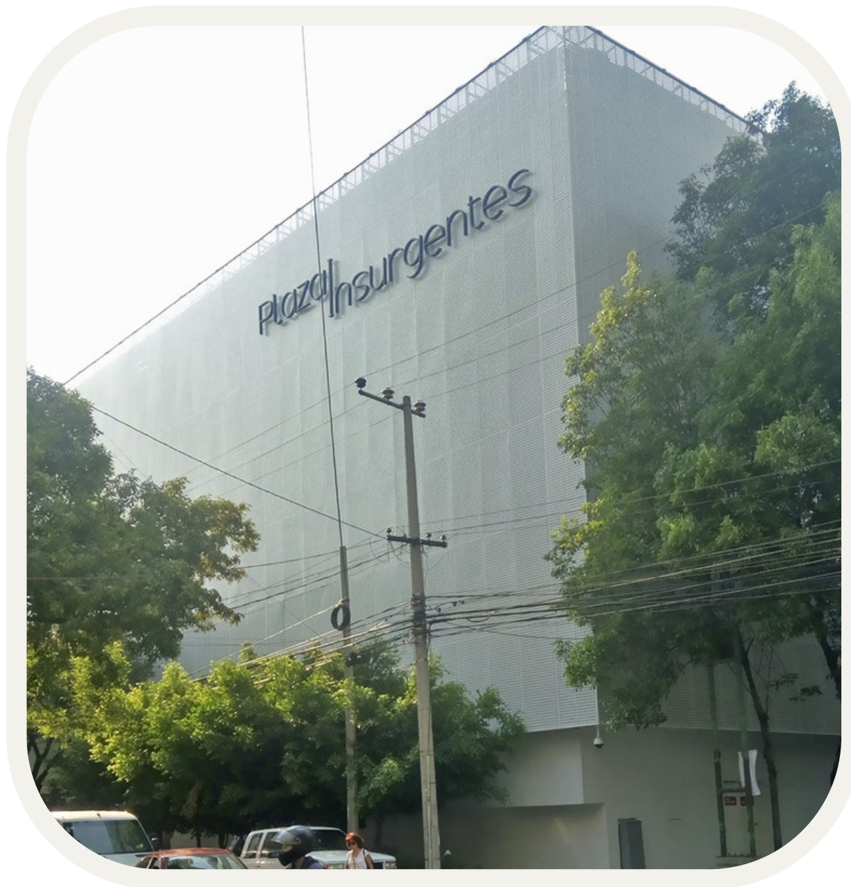
Plaza Insurgentes Suministro e Instalación de Lamina Perforada
