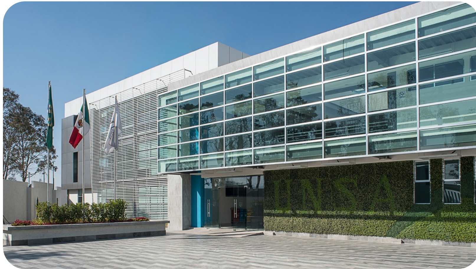
Universidad de Salud Toluca Suministro e instalación de panel de aluminio
