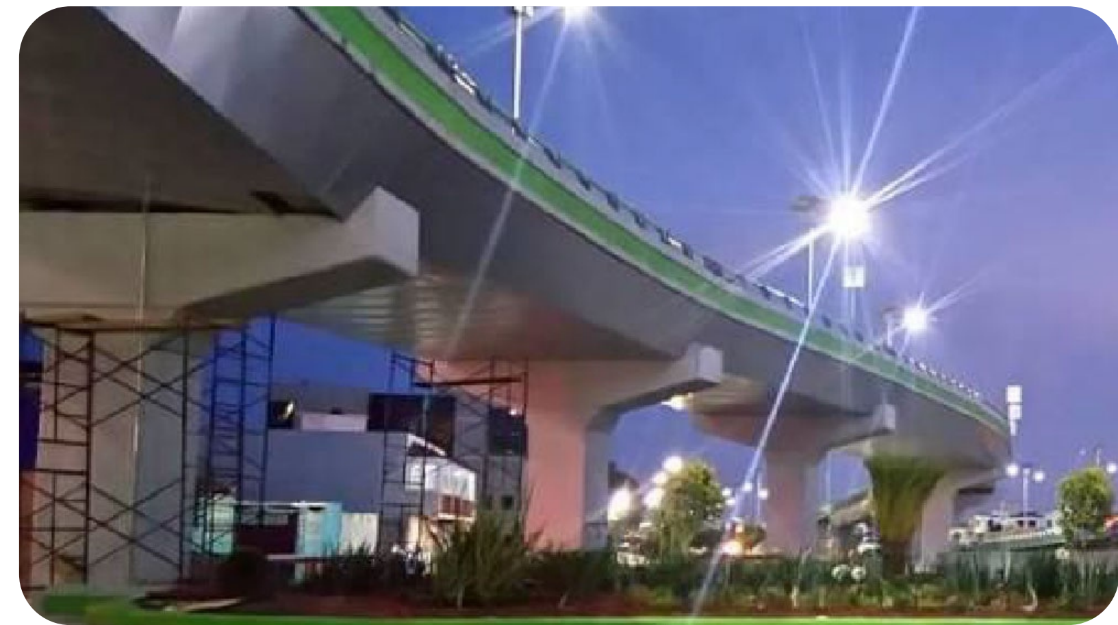
Puentes Elevados Suministro e instalación de panel de aluminio
